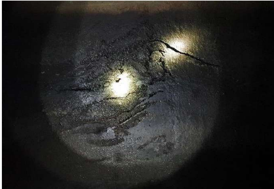
ფოტო 6-2: გვირაბში არსებული ეროზირებული უბნები: ღრმად ეროზირებული მონაკვეთი, პკ 47+15 (30 სმ-მდე)
