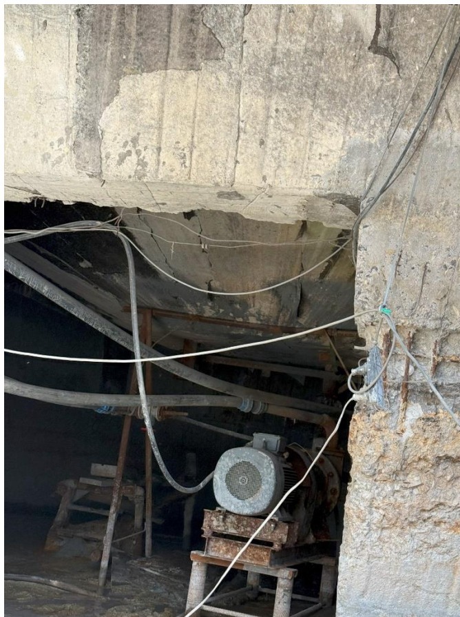
Рисунок 5.1.11. Оборудование под днищем сгустителя. Доступа нет
