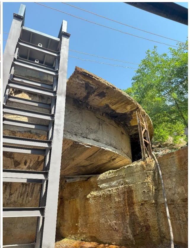
Рисунок 5.1.5. Смонтированная рама под новый сгуститель
