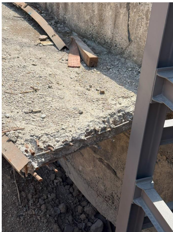
Рисунок 5.1.14. Демонтаж части площадки для рамы сгустителя. Армирование площадки
