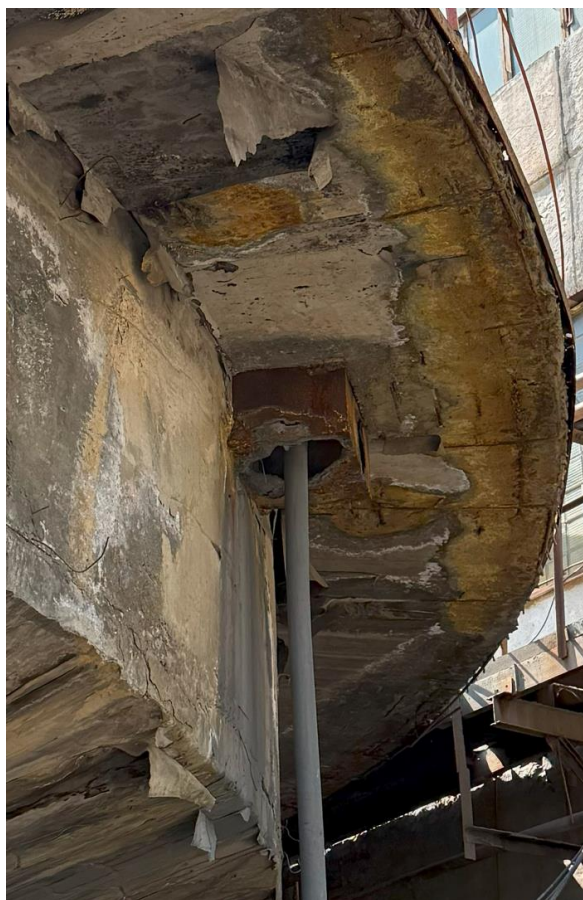
Рисунок 5.1.25. Сливное отверстие. Массово разрушено по причине агрессивности среды
