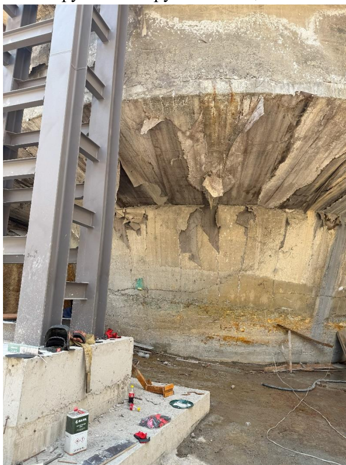
Рисунок 5.1.10. Разрушение наружной гидроизоляции чаши. Разрушение наружного защитного слоя бетона чаши. Следы высолов на бетоне
