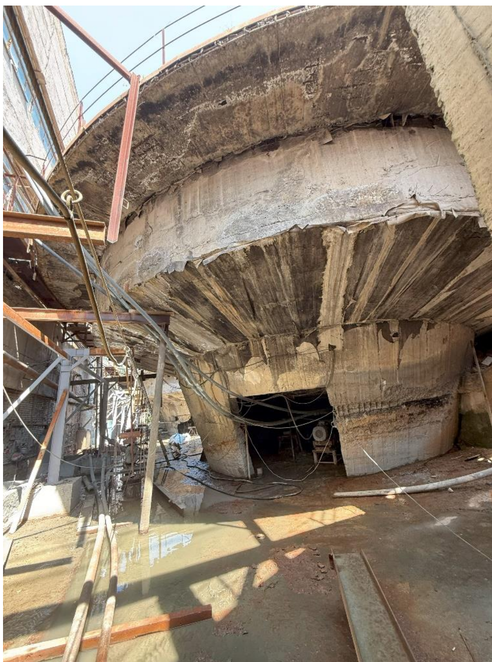
Рисунок 5.1.1. Общий вид железобетонной чаши сгустителя
