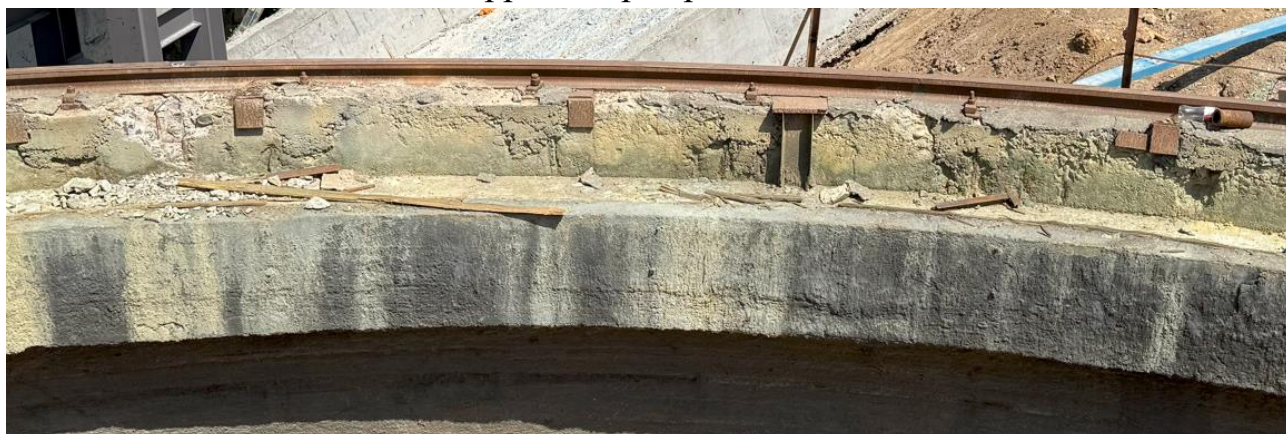
Рисунок 5.1.29. Локальные участки ремонта под крепления рельса скребка
