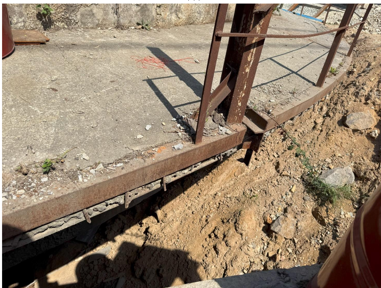
Рисунок 5.1.15. Смонтированный уголок под ограждение по обрезау площадки
