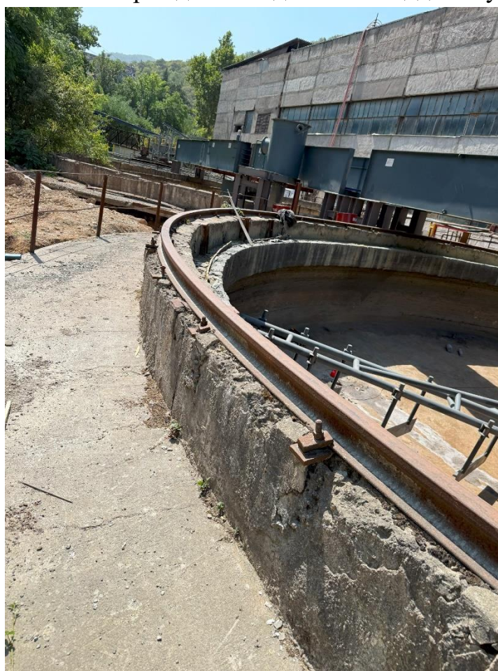
Рисунок 5.1.17. Смотримый рельс по обрезу стены
