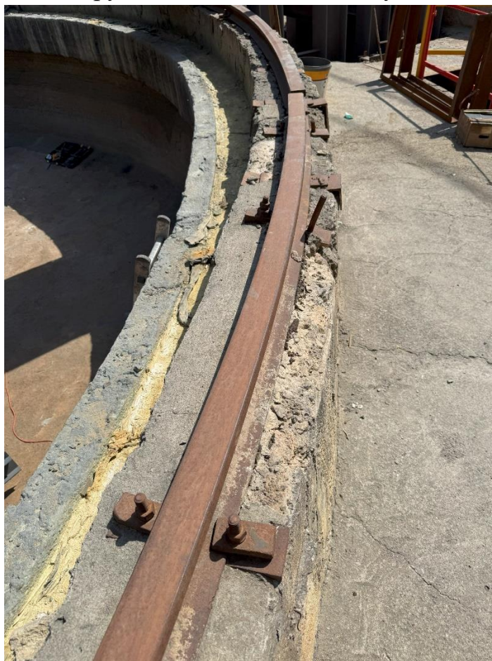
Рисунок 5.1.12. Смонтированный рельс на конструкцию стены сгустителя. Рельс не эксплуатируется
