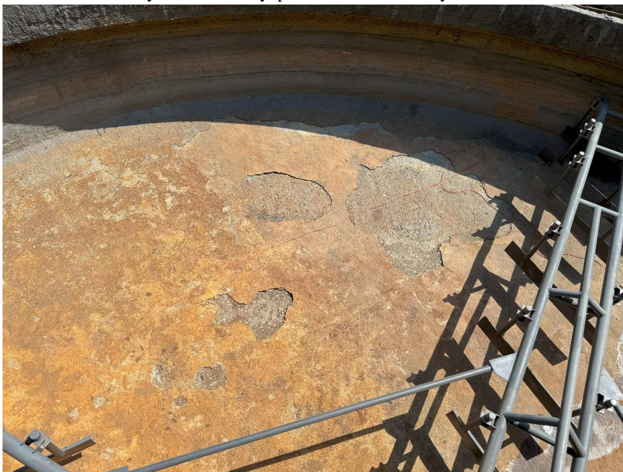
Рисунок 5.1.3. Кислотоупорное покрытие чаши. Локальные участки разрушения
