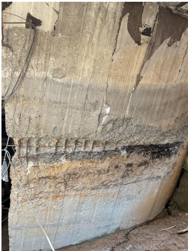
Рисунок 5.1.9. Недостаточное уплотнение бетона. Разрушение наружной гидроизоляции чаши. Разрушение наружного защитного слоя бетона чаши
