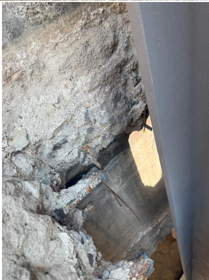
Рисунок 5.1.4. Армирование ходовой площадки. Демонтированное отверстие под раму нового сгустителя
