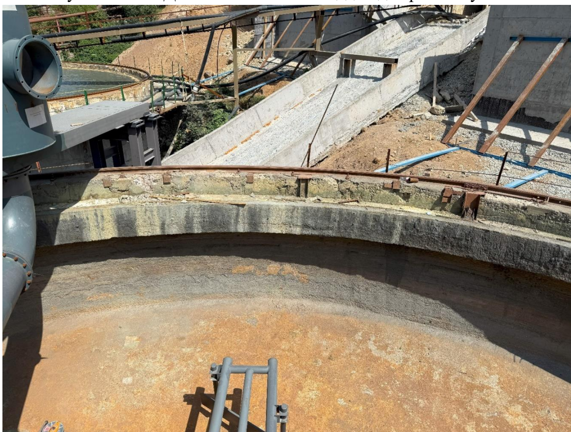
Рисунок 5.1.13. Общий вид желоба. Кислотоупорная стяжка. Локальные участки разрушения и загрязнения
