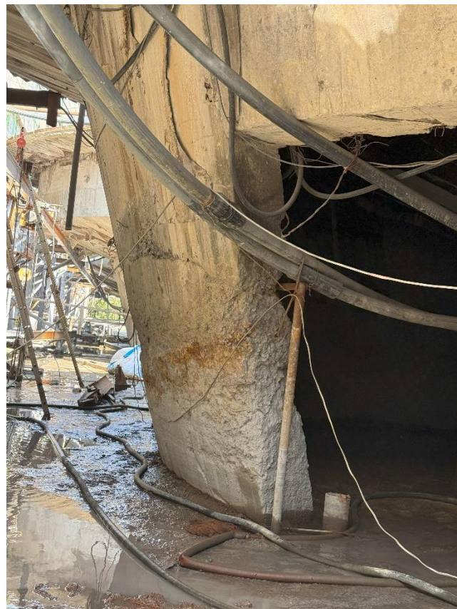
Рисунок 5.1.9. Недостаточное уплотнение бетона. Разрушение наружной гидроизоляции чаши. Разрушение наружного защитного слоя бетона чаши
