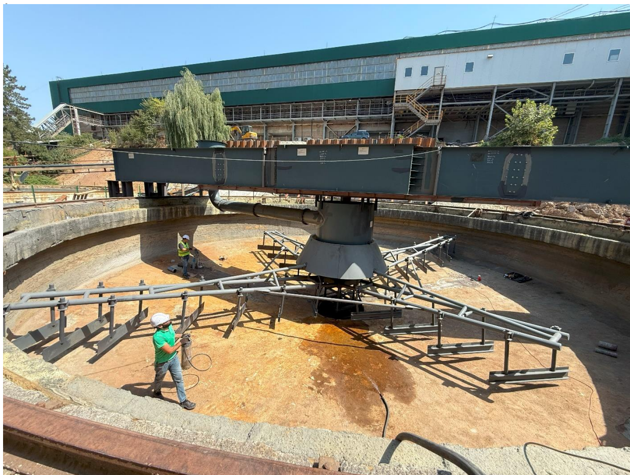
Рисунок 5.1.2. Внутренняя часть чаши сгустителя
