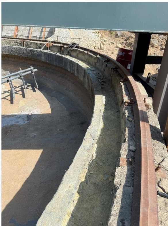
Рисунок 5.1.26. Желоб по верхней части чаши. Массово засорен застывшими продуктами работы сгустителя
