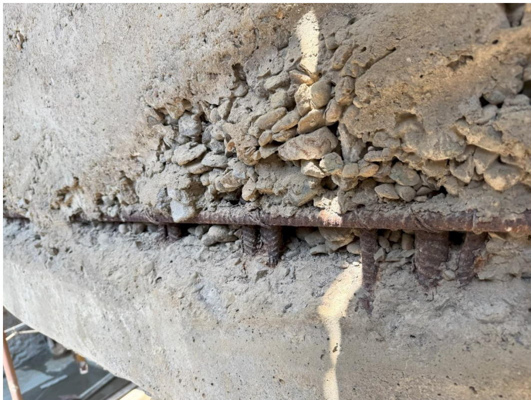
Рисунок 5.1.22. Плохо уплотненный бетон. Отсутствие защитного слоя бетона. Поверхностная коррозия армирования
