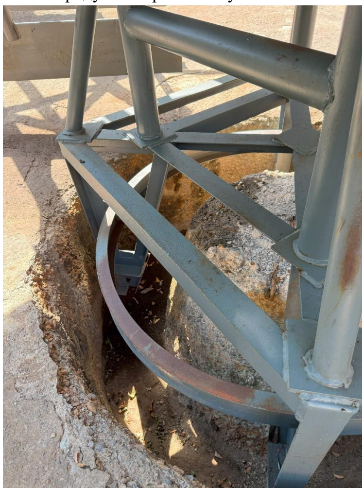
Рисунок 5.1.27. Центральная часть дна чаши. Место монтажа «нового» сгустителя
