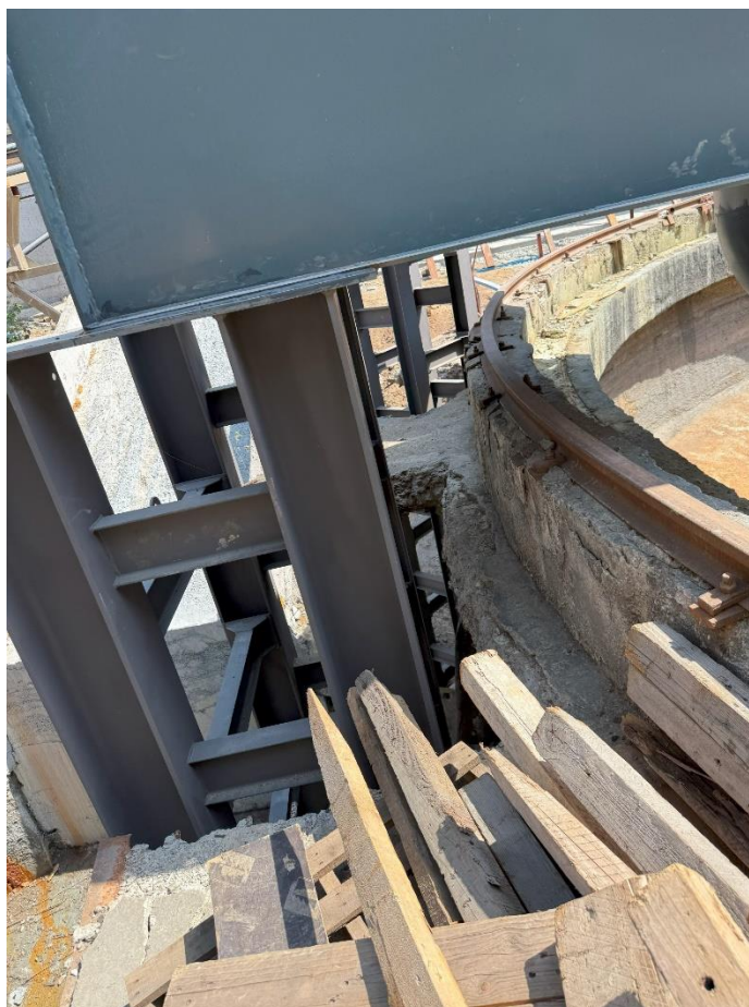
Рисунок 5.1.12. Демонтаж части площадки для рамы сгустителя
