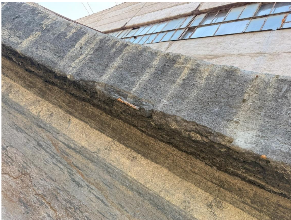
Рисунок 5.1.28. Желоб по верхней части чаши. Массово засорен застывшими продуктами работы сгустителя. Локальные участки разрушения защитного слоя и коррозии армирования
