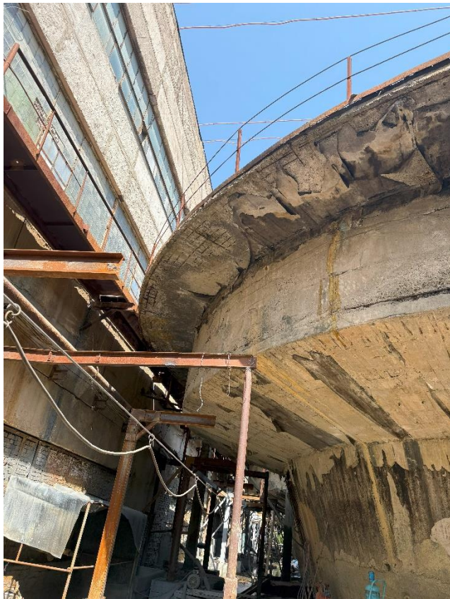
Рисунок 5.1.6. Разрушение наружной гидроизоляции чаши. Разрушение наружного защитного слоя чаши
