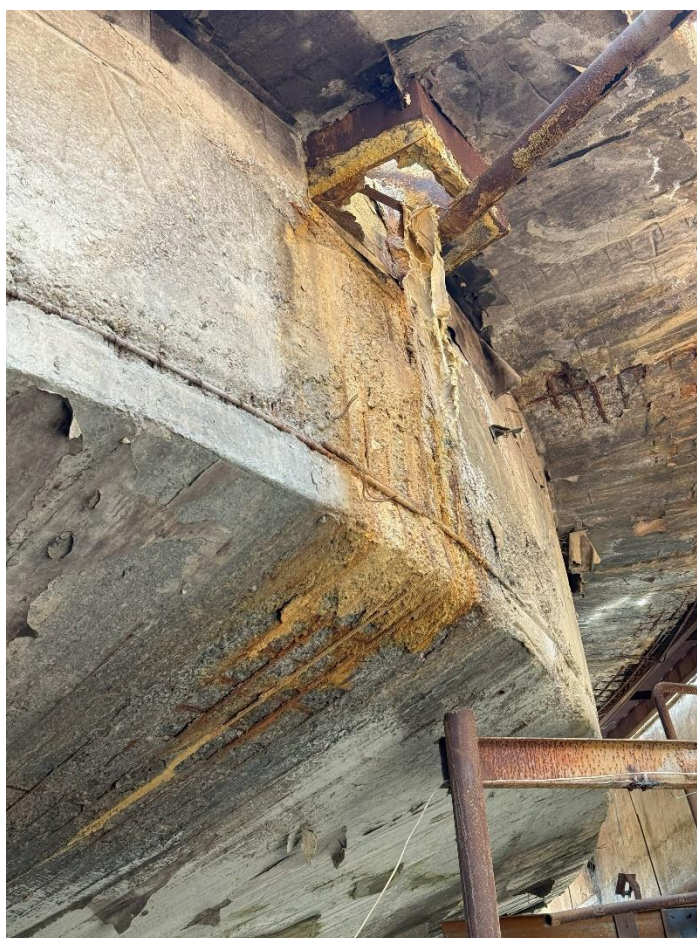
Рисунок 5.1.25. Сливное отверстие. Массово разрушено по причине агрессивности среды
