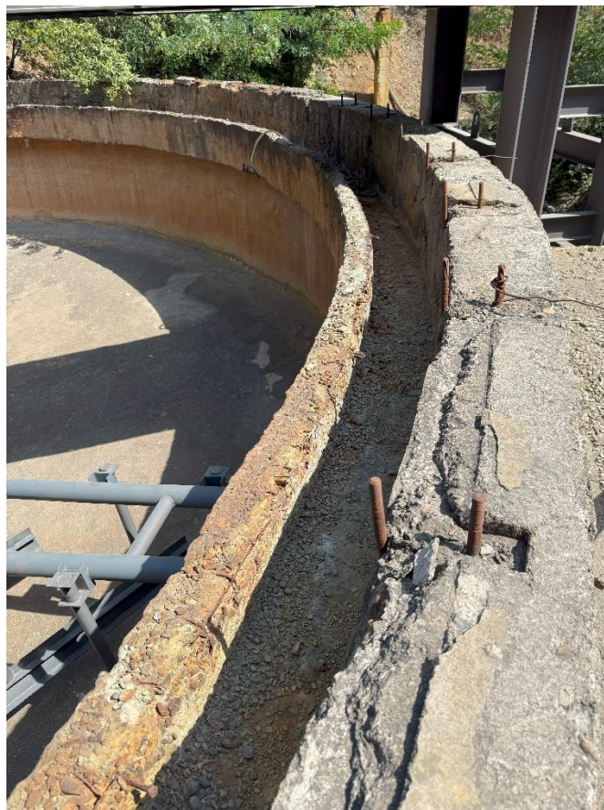
Рисунок 5.1.22. Разрушение защитного слоя желоба с коррозией армирования
