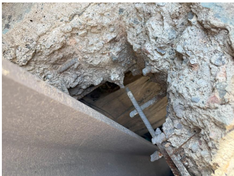
Рисунок 5.1.4. Армирование ходовой площадки. Демонтированное отверстие под раму нового сгустителя
