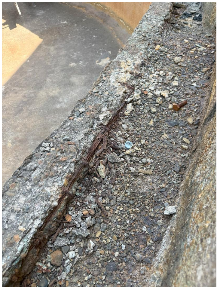
Рисунок 5.1.20. Засорение желоба. Разрушение железобетона
