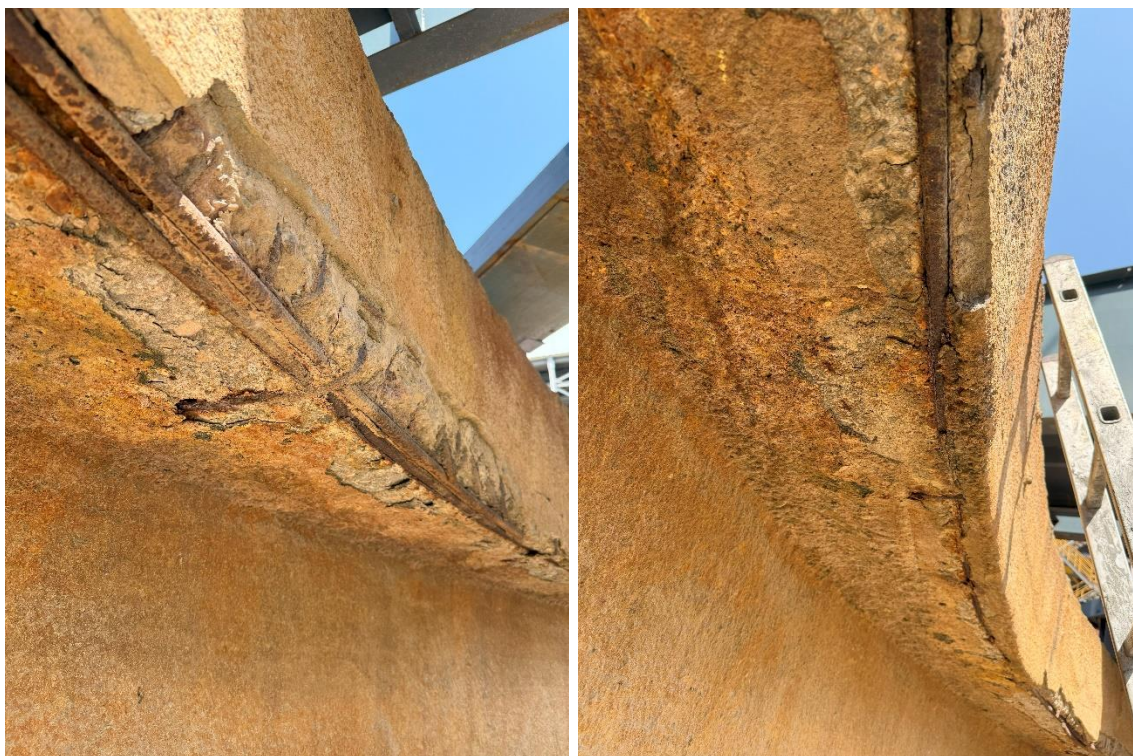
Рисунок 5.1.26. Разрушение кислотоупорного покрытия с наружной части желоба с коррозией армирования
