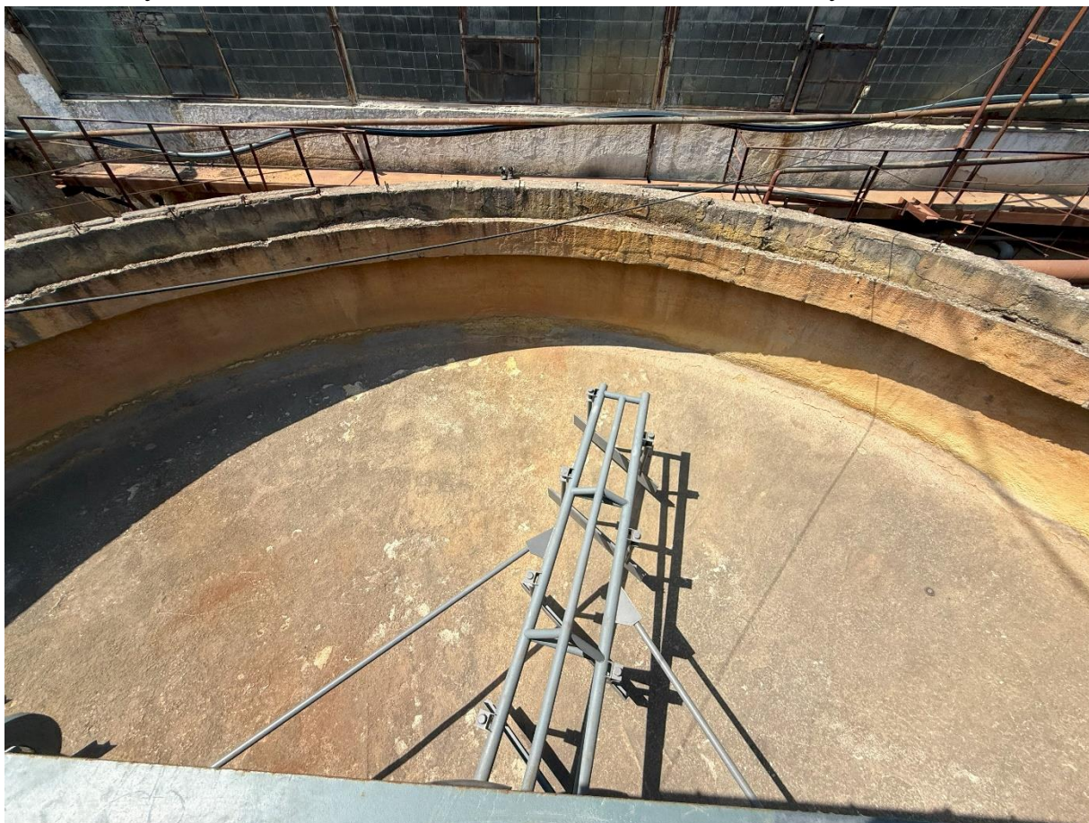
Рисунок 5.1.2. Внутренняя часть чаши сгустителя
