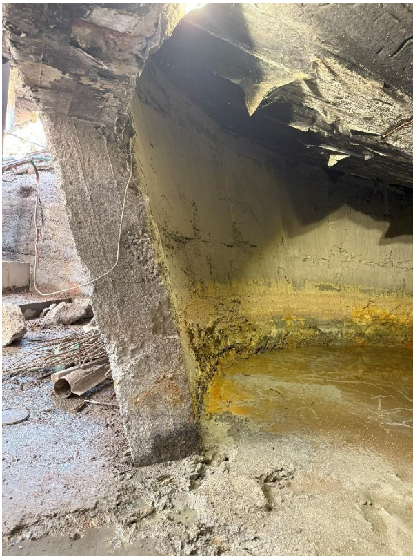
Рисунок 5.1.9. Внутренняя часть чаши. Недостаточное уплотнение бетона. Скопление продуктов работы сгустителя
