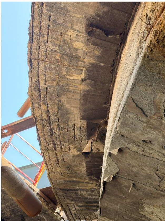
Рисунок 5.1.14. Демонтаж части площадки для рамы сгустителя. Разрушение защитного слоя бетона площадки
