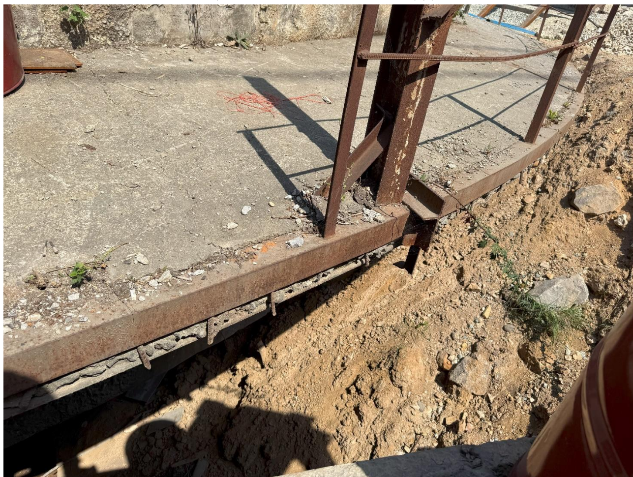
Рисунок 5.1.15. Смонтированный уголок под ограждение по обресту площадки
