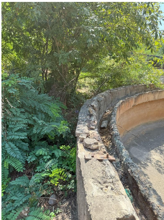
Рисунок 5.1.12. Отсутствие ограждение на части площадки. Биологические образования (деревья) ближе 5м к конструкции сгустителя
