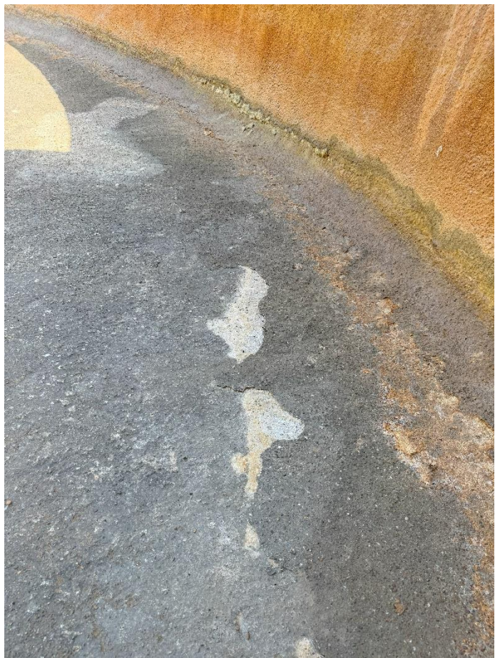
Рисунок 5.1.28. Участки разрушения кислотоупорного покрытия чаши
