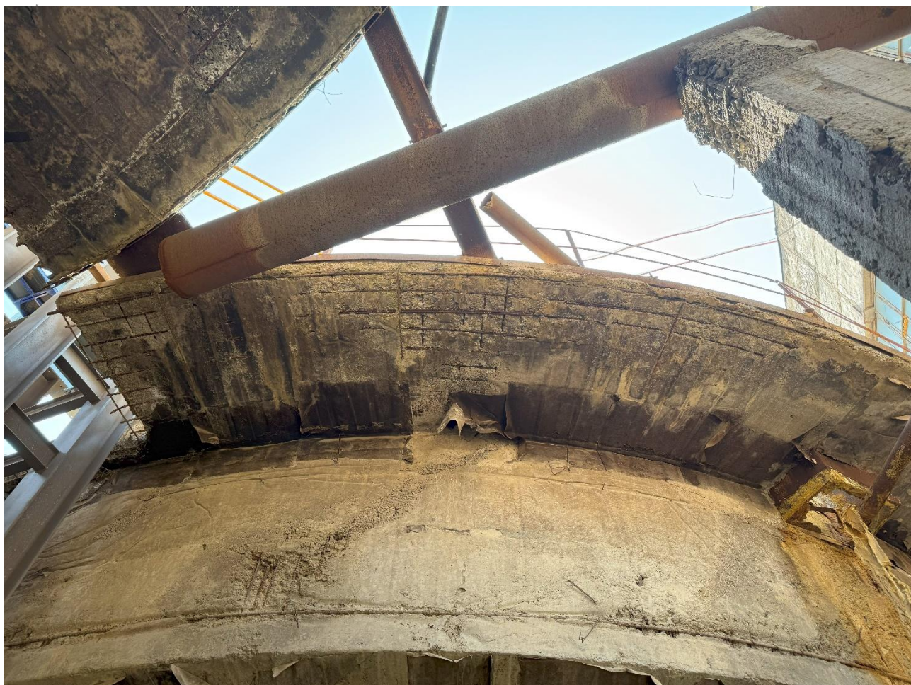
Рисунок 5.1.7. Разрушение наружной гидроизоляции чаши. Разрушение наружного защитного слоя бетона чаши
