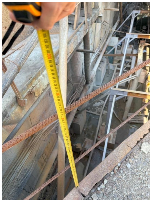
Рисунок 5.1.24. Высота ограждения 800мм, для работы на высоте необходимо не менее 1100мм.
