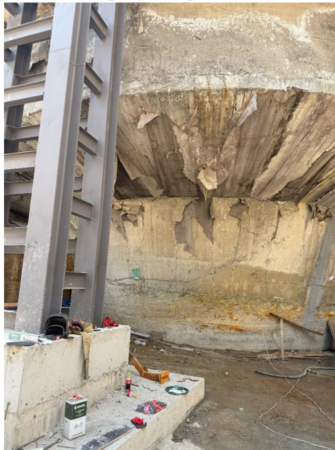
Рисунок 5.1.10. Разрушение наружной гидроизоляции чаши. Недостаточное уплотнение бетона. Следы высолов на бетоне
