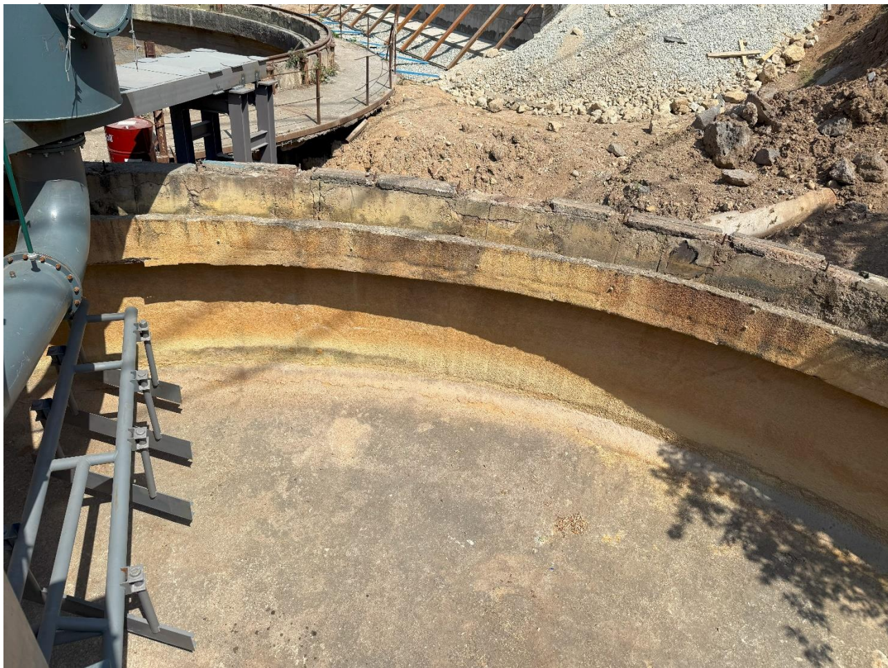
Рисунок 5.1.3. Кислотоупорное покрытие чаши. Локальные участки разрушения вертикальной стены
