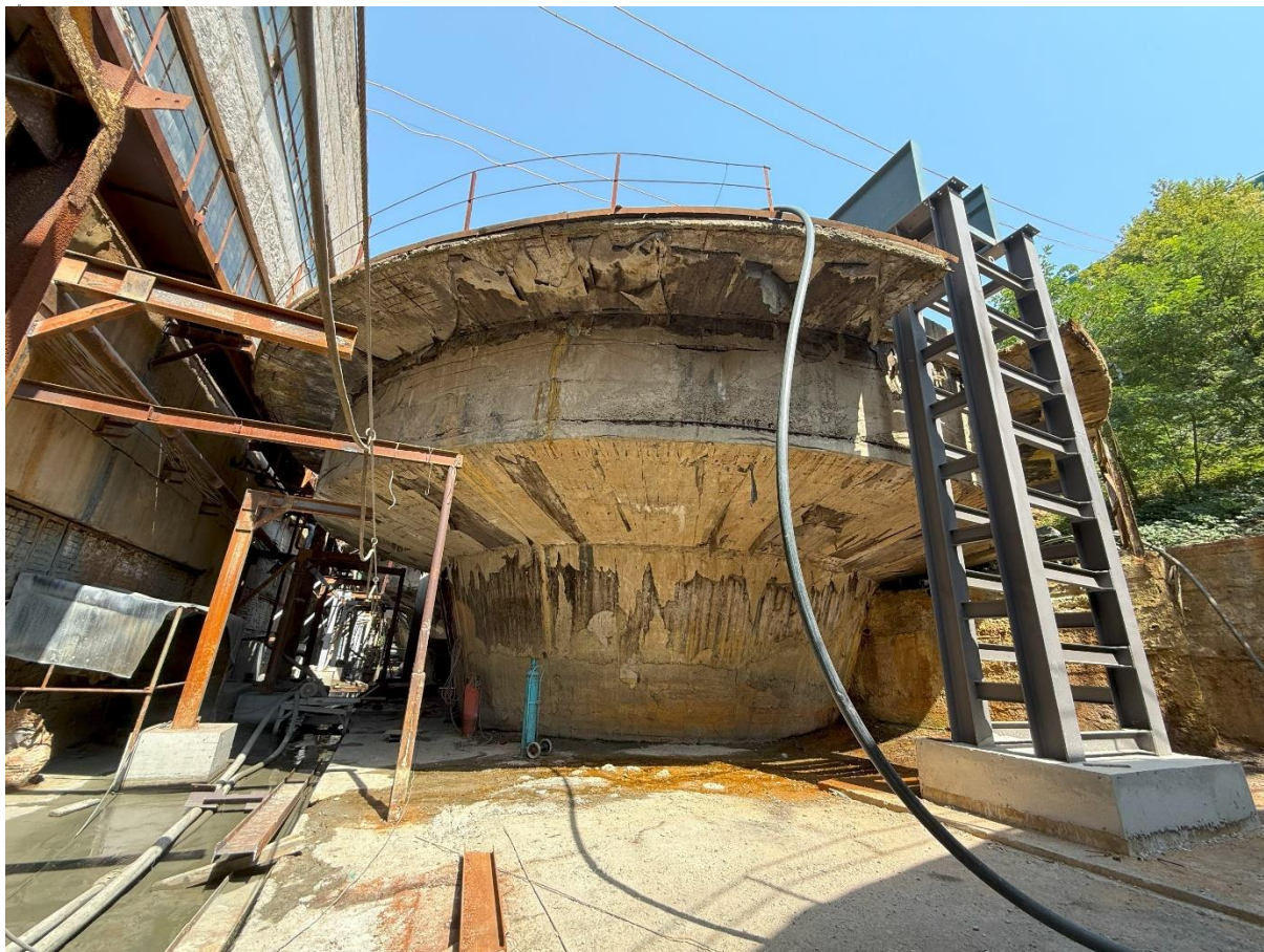
Рисунок 5.1.1. Общий вид железобетонной чаши сгустителя №5
