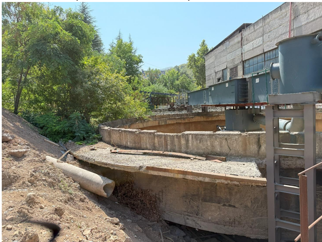
Рисунок 5.1.12. Отсутствие ограждение на части площадки. Биологические образования (деревья) ближе 5м к конструкции сгустителя
