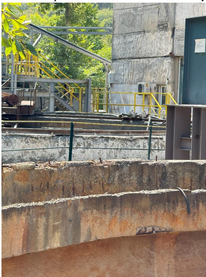
Рисунок 5.1.17. Общий вид желоба. Демонтированный рельс. Разрушение защитного слоя с коррозией армирования
