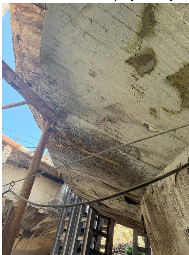
Рисунок 5.1.6. Разрушение наружной гидроизоляции чаши. Разрушение наружного защитного слоя бетона чаши
