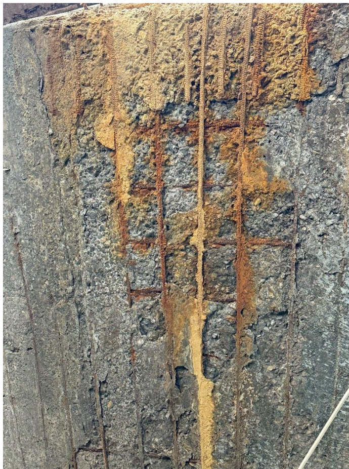
Рисунок 5.1.5. Коррозия наружной поверхности чаши сгустителя по причине агрессивного воздействия продуктов сгустителя
