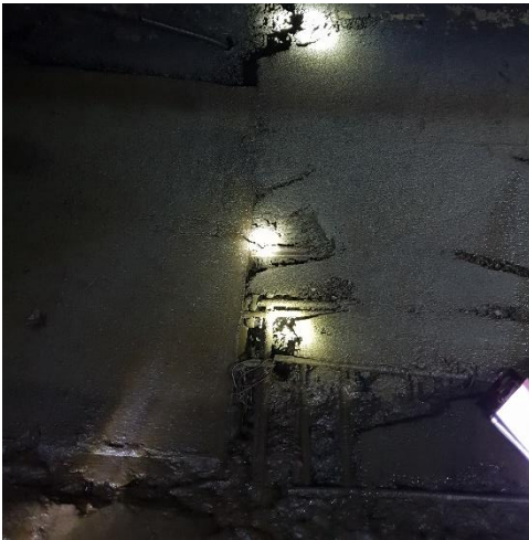
ფოტო 6-4: გვირაბში არსებული ეროზირებული უბნები: ეროზირებული უბანი არმატურის გაშეშვლებით (მარცხენი); ღრმად ეროზირებული მონაკვეთი (მარჯვნივ)
