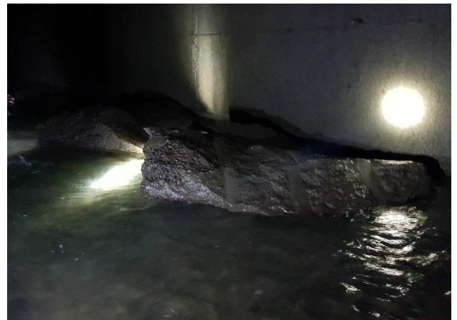
ფოტო 6-7: თაღიდან ჩამონგრეული ბეტონის მოსახვის ნამსხვრევები (პკ 10+90)
