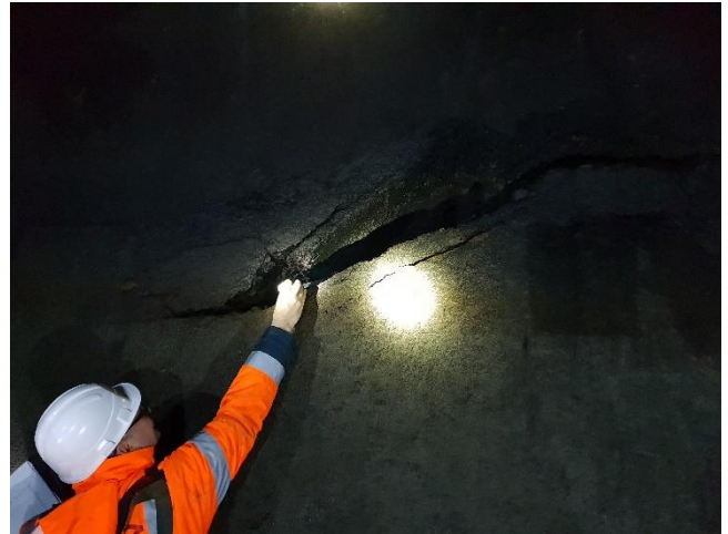
ფოტო 6-4: გვირაბში არსებული ეროზირებული უბნები: ეროზირებული უბანი არმატურის გაშეშვლებით (მარცხენი); ღრმად ეროზირებული მონაკვეთი (მარჯვნივ)
